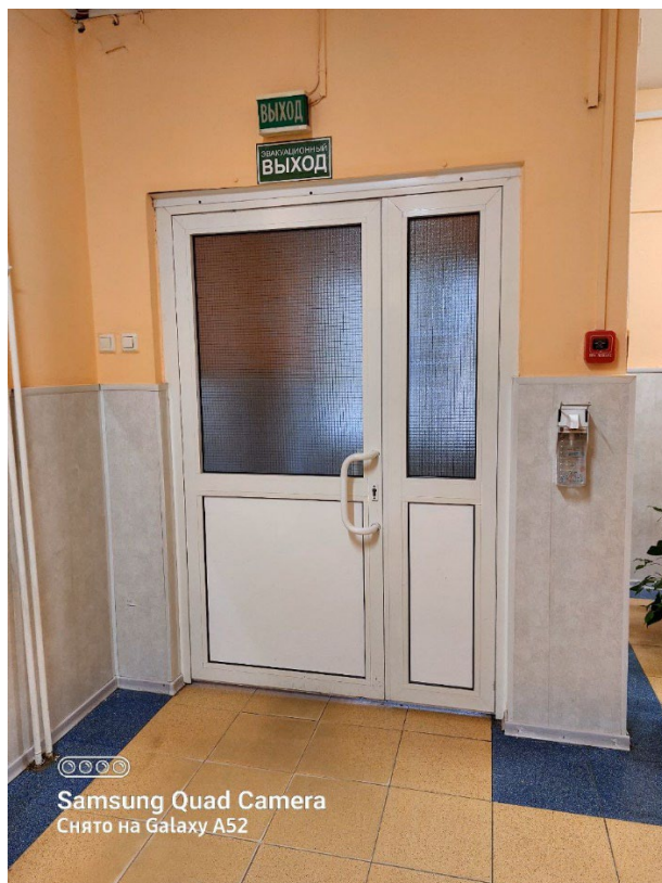
Фото № 61. Эвакуационный выход.
